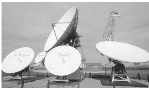
Stații terestre de retransmisie din componența liniilor cu unde radio
