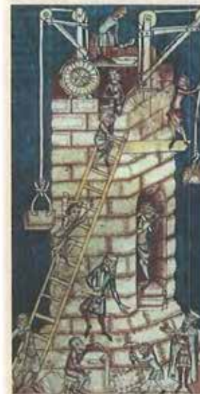
Строительство башни в средневековом городе
