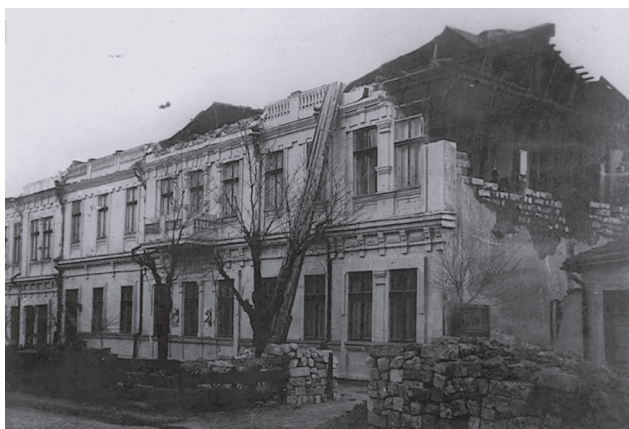
Рис. 20. Здание в Кишинэу, разрушенное землетрясением 10 ноября 1940 г.
