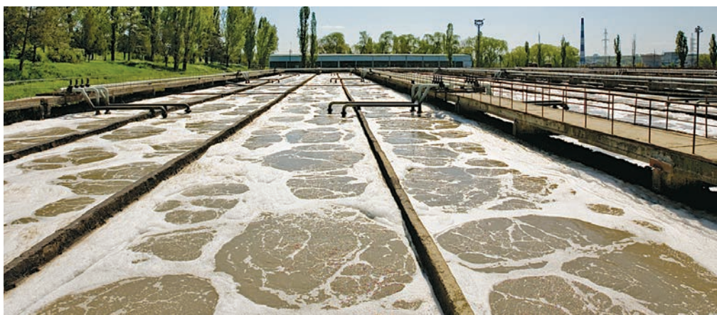
Рис. 101. Очистные сооружения муниципия Кишинэу, производительностью 6 600 м 3 /час
