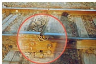
3.15. Зазоры между железнодорожными рельсами
