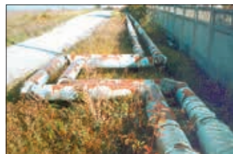
3.16. Компенсирующая петля теплотрассы
