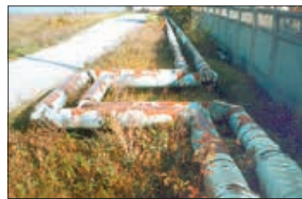
3.16. Buclă compensatoare a rețelei termice
